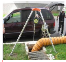
雨排水溝/下水道
