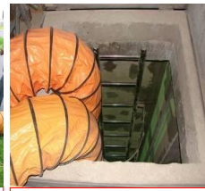
陰井/地下儲槽
