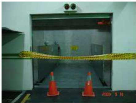
地下1樓 (B1) 停車設備外觀
